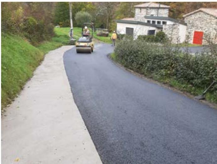
Dans la continuité du programme pluriannuel, la chaussée de la route de la Boissonnade a été refaite en enrobés entre le pont du Moulinage et la route de la Rouvière. Le fossé en béton existant qui posait des problèmes de sécurité a été busé et recouvert d'une dalle béton pour permettre aux véhicules de se croiser plus facilement.
